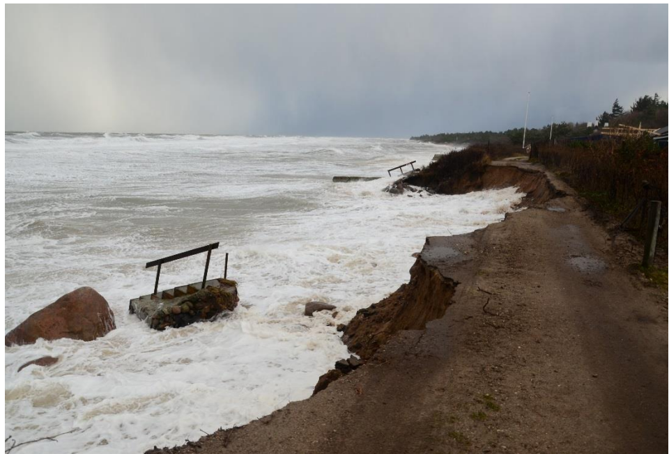
Figur 4.8 Akut erosion af skrånningen ved Havstokken, Udsholt, Gribskov Kommune, under stormen Bodil 06.12.2013
