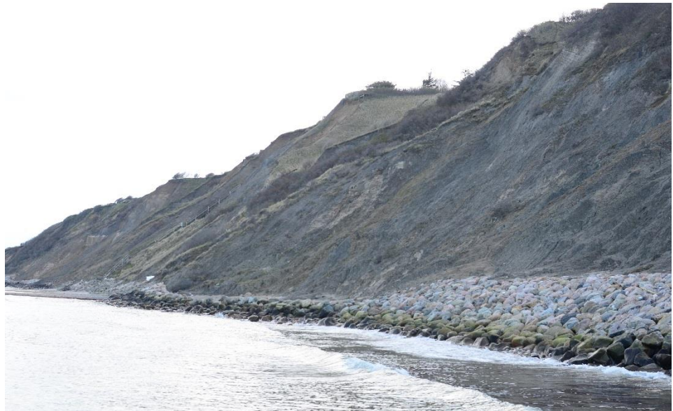
Figur 4.6 Stejl og høj skråning og lav skråningsbeskyttelse ved Salgårdshøj. Der er ingen strand foran skråningsbeskyttelsen.
