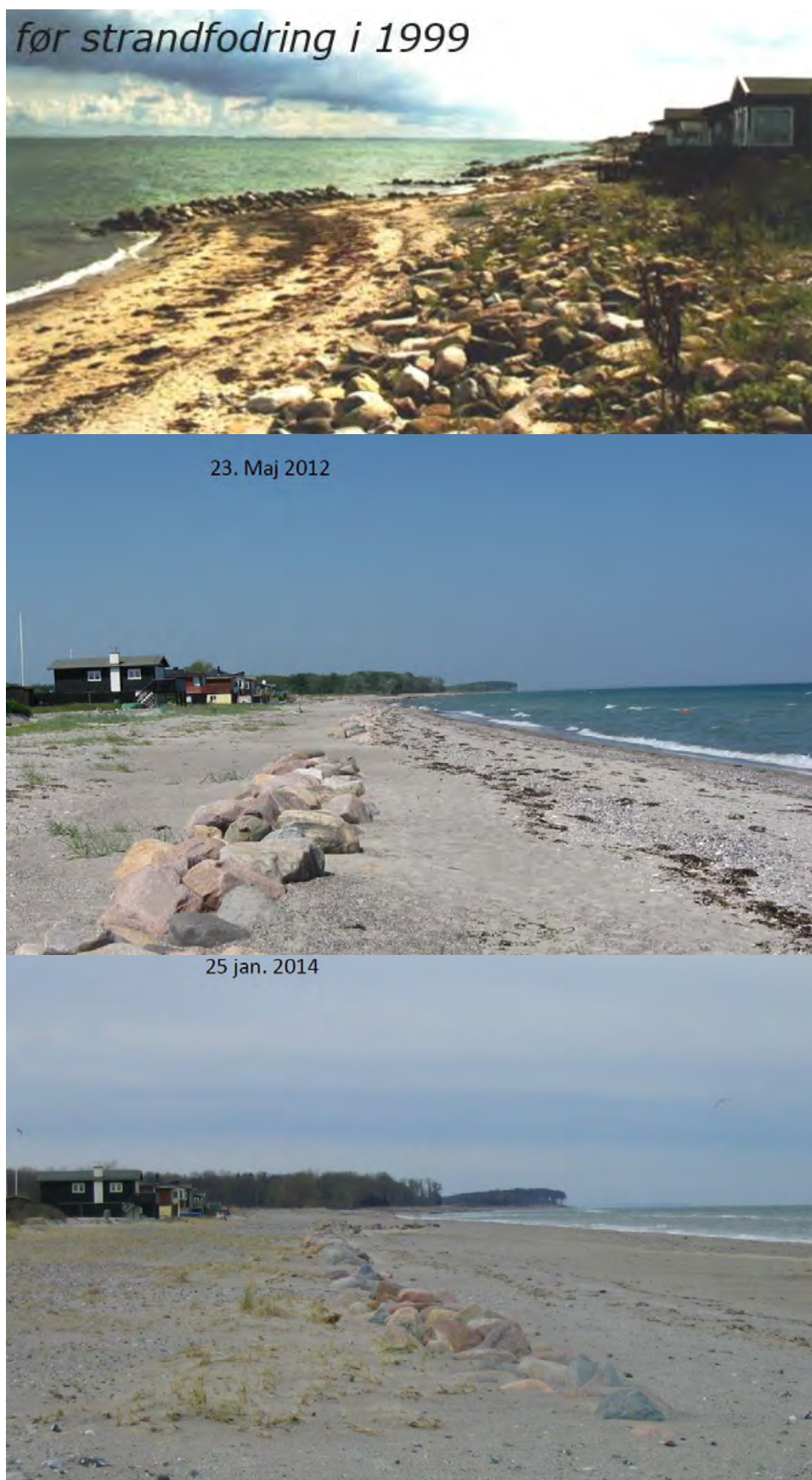
Figur 3-30 Effekt af løbende strandfodring på Nordfyn. 1999 før fodring, maj 2012 før stormen Bodil, januar 2014 efter stormen Bodil
