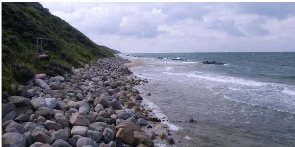
Figur 7-50 Kraftig skråningsbeskyttelse ved Kystvej, hvor stranden er forsvundet, 2009
