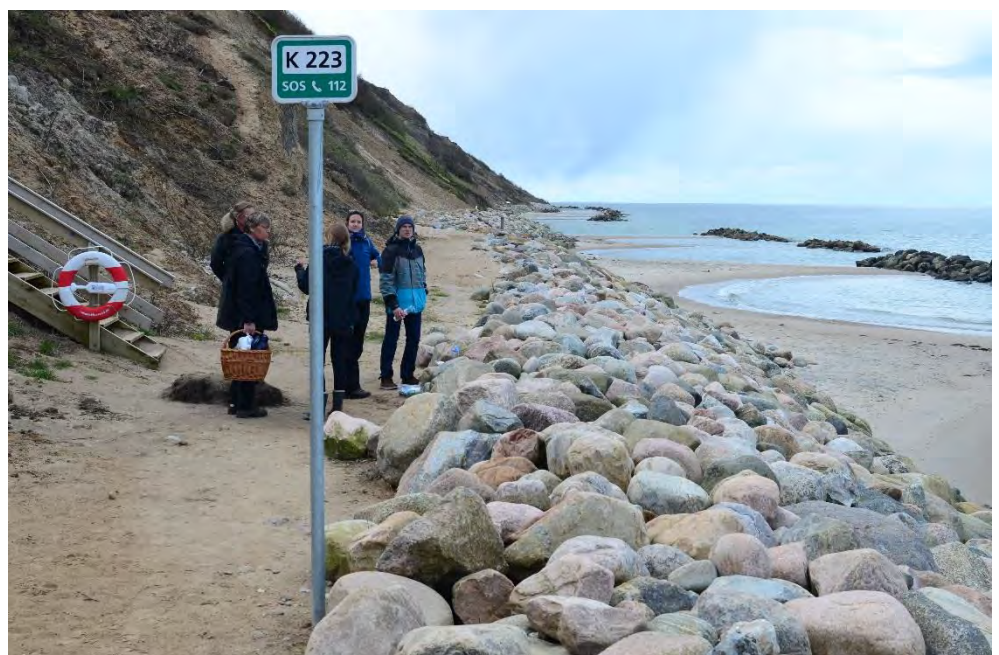
Figur 7-57 Ny-renoverede skråningsbeskyttelse og adgangsvej til stranden ved Markvænget, 2016
