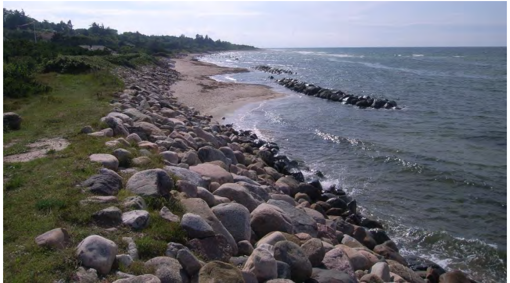
Figur 7-80 Skråningsbeskyttelse og bølgebryder ved Strandbakkevej
