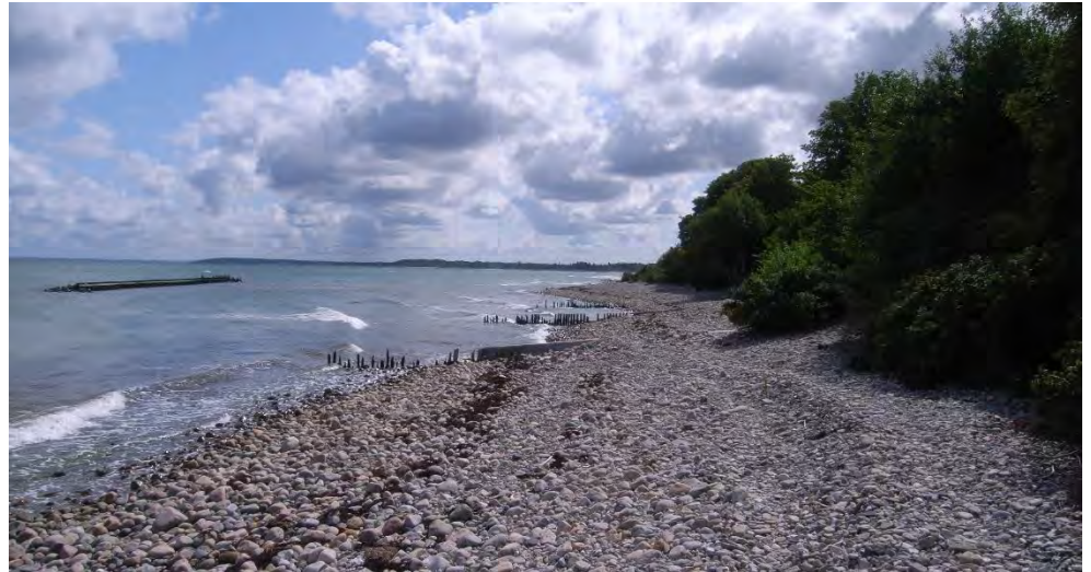
Figur 7-101 Små nedslidte træhøfder og ralstrand samt den store bølgebryder ved Munkerup Gård, 2009
