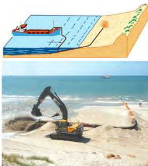
Figur 2-15 Indpumpning og fordeling af sand på stranden
