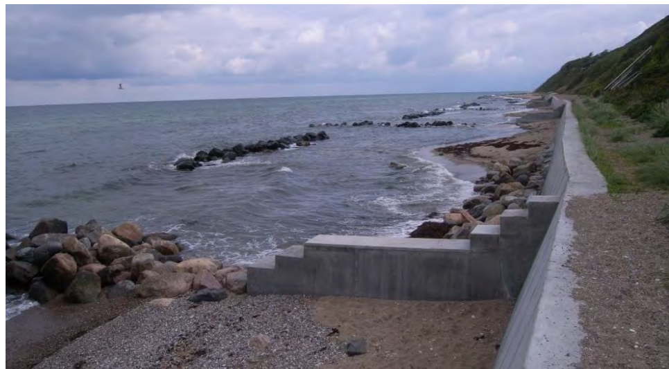
Figur 7-45 Stor betonmur langs foden af skråning øst for Tisvilde, 2009
