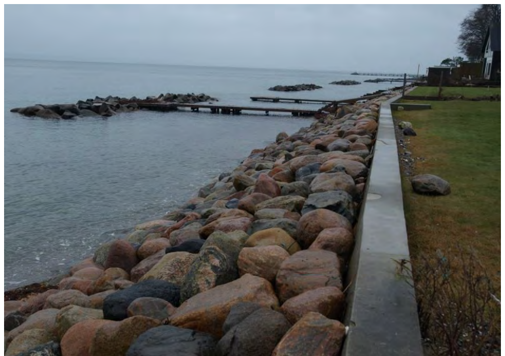
Foto 7-139 Typisk skråningsbeskyttelse ved Ålsgårde med betonmur og stenskråning foran
