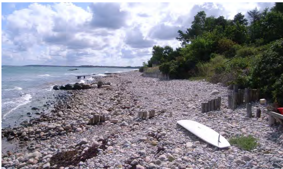
Figur 7-100 Små nedslidte træhøfder og ralstrand ved Jacobslystvej, 2009
