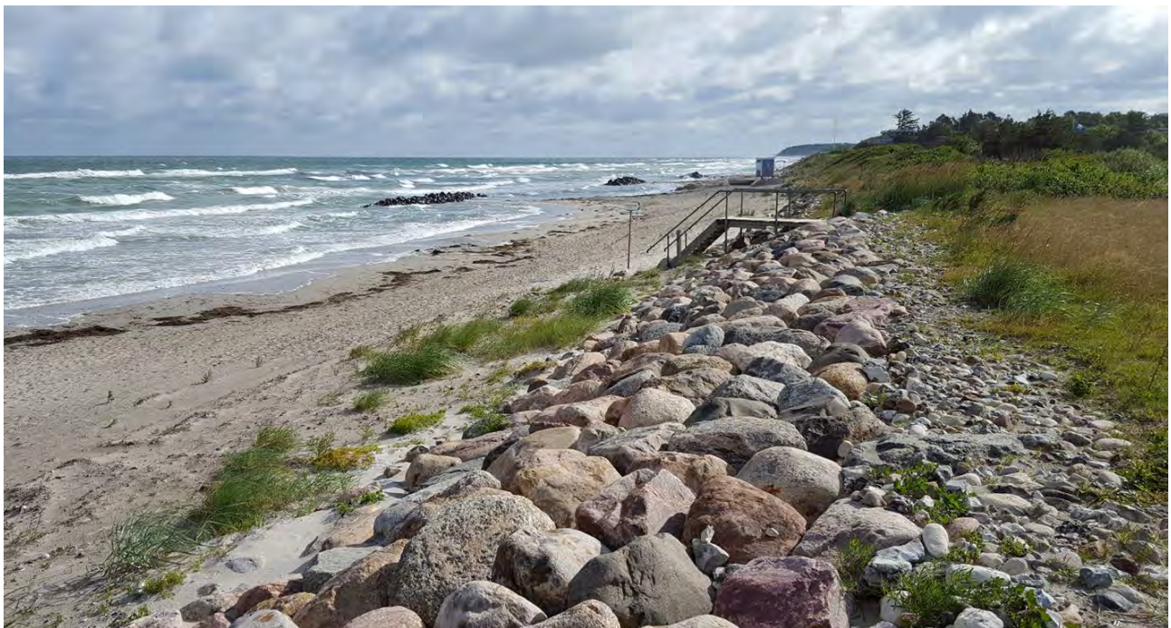
Figur 7-5 Højvandsbeskyttelse i form af ler-dige beskyttet mod erosion med skråningsbeskyttelse, Kikhavn
