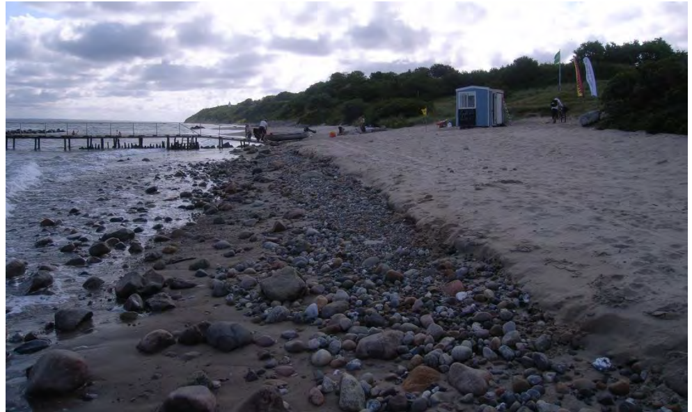
Figur 7-94 Et tyndt lag sandfodring dækker midt på sommeren stenstranden ved Strandbakkerne, 2009
