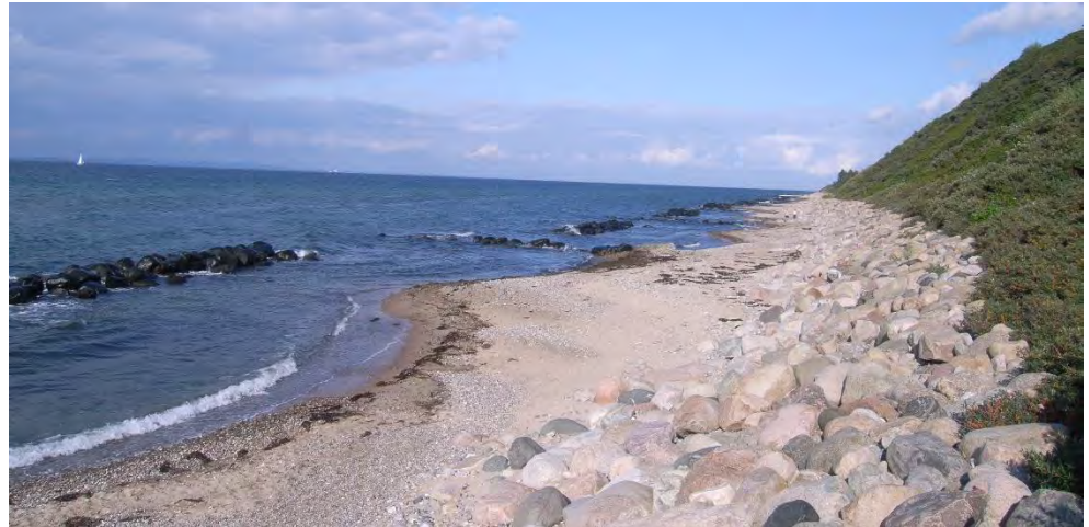
Figur 7-87 Smal stenstrand beskyttet af små bølgebrydere og skråningsbeskyttelse ved Gilbjergstien, 2009
