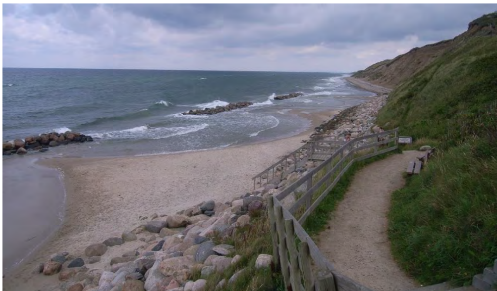
Figur 7-54 Adgangsvej til stranden ved Markvænget. Kysten er beskyttet af skråningsbeskyttelse og bølgebrydere, men stranden er næsten forsvundet, 2009
