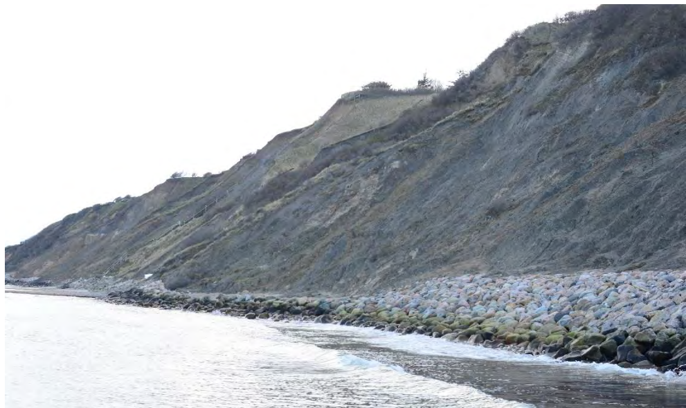
Figur 2-2 Meget stejl og høj skråning og lav skråningsbeskyttelse ved Salgårdshøj
