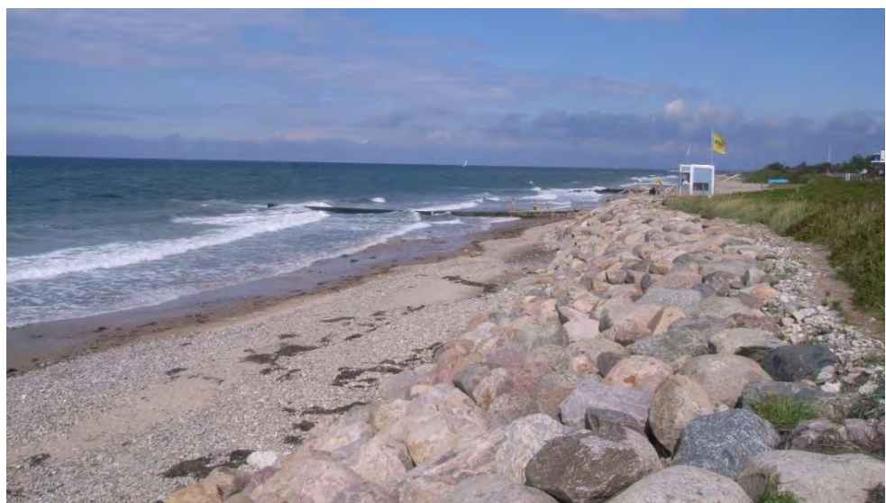
Figur 7-72 Stor ny fremskudt skråningsbeskyttelse ved Rågeleje Strandpark
