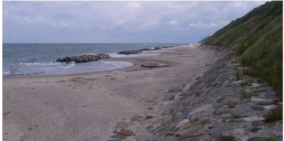
Figur 7-48 Bølgebryderfelt ved Nordre Strandvej, 2009
