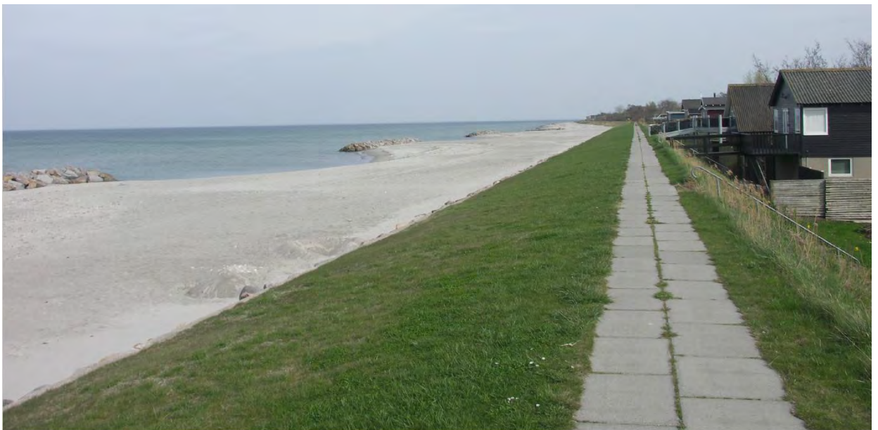
Figur 3-29 Strækning med nye bølgebrydere og skråningsbeskyttelse samt vedligeholdelses strandfodring ved Tørresø, Nordfyn
