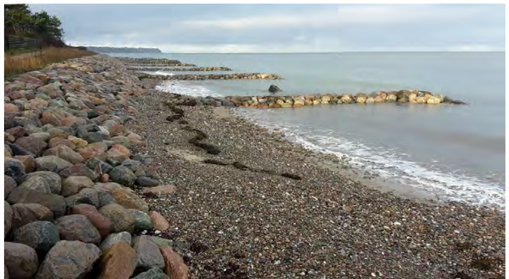
Figur 7-110 Ny-renoveret stenhøfder og skråningsbeskyttelse med ralstrand foran og Nordkyststien ved Villingebæk Hage, 2016
