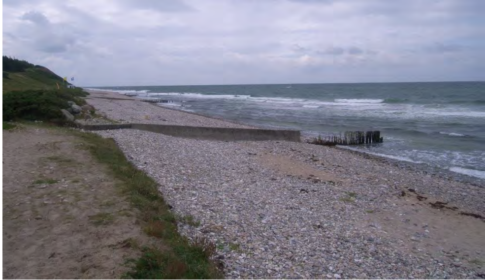
Figur 7-64 Bred rullestensstrand med nedslidte hølfer ved Strandbjerggård, 2009
