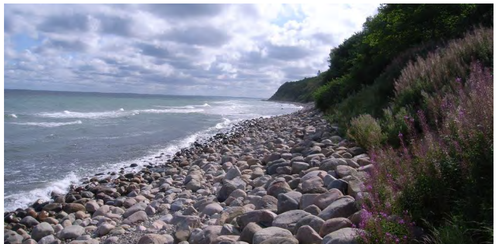
Figur 7-95 Kraftig skråningsbeskyttelse uden strand øst for Strandbakkerne, 2009
